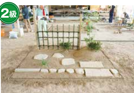
指定された区画内に、四つ目垣製作、緑石・敷石・飛石敷設、築山、整地及び植栽作業をおこなう。
